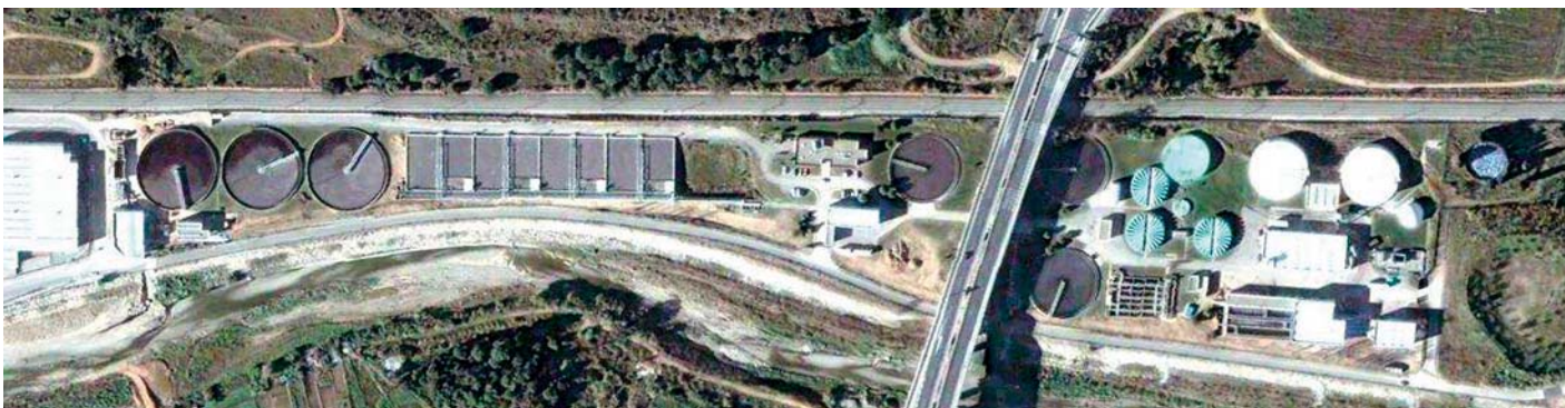
ČOV Tarrasa ve výstavbě
