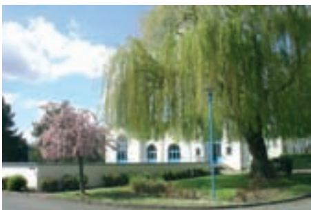
Úpravna vody Vigneux sur Seine
