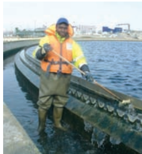
Čištění přepadové hrany dosazovací nádrže
