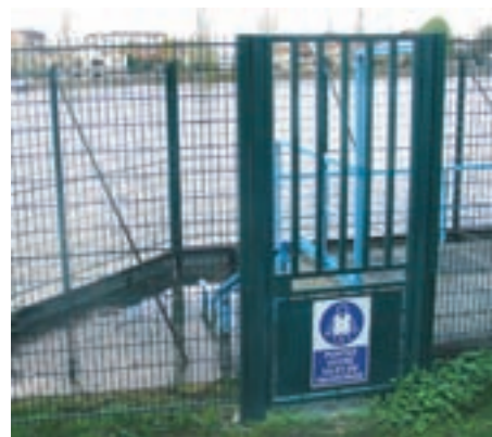
ÚV stojí bezprostředně na břehu Seiny, z níž odebírá vodu
