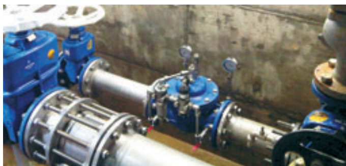
Obr. 5: Instalace PICO® Membránového regulačního ventilu k redukci výstupního tlaku v šachtě
