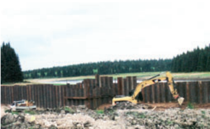
Obr. 7: Štětová stěna pro utěsnění hráze budované předzdrže; v pozadí je vidět sníženou hladinu přehrady Carlsfeld (srpen 2010)
