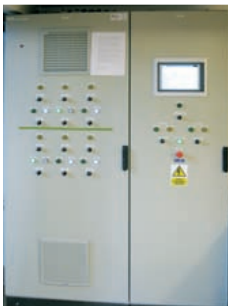
Obr. 3: Pohled na skříňový rozvaděč ČS s 10" dotykovým panelem
