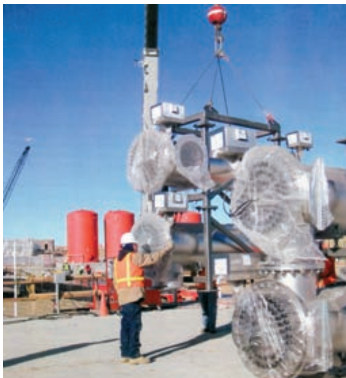
Obr.: Program zásobování pitnou vodou v prérii (PrairieWater Program) v městě Aurora (Colorado – USA) je příkladem typu projektu trvale udržitelného zásobování pitnou vodou. Několik společností v jeho rámci řeší, jak se město v budoucnosti vyrovná se suchem a rostoucí potřebou vody.
