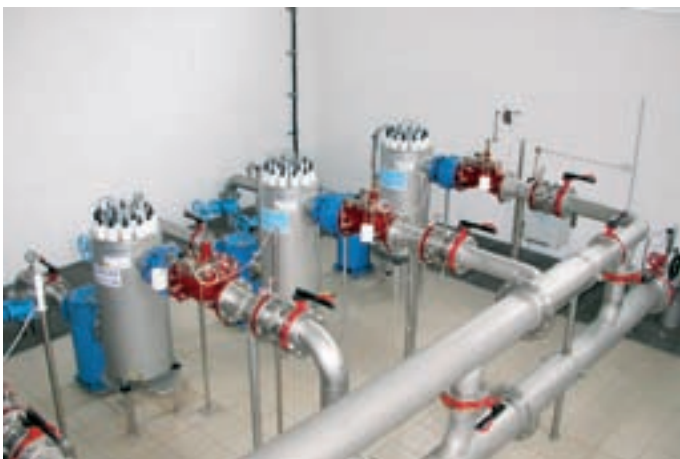
Obr. 2: Sektor UV lamp na úpravě (I), za zmínku stojí především dokonalá čistota podlah na všech místech úpravní
