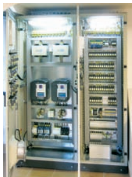
Obr. 3: Pohled na skříňový rozvaděč ČS s 10" dotykovým panelem
