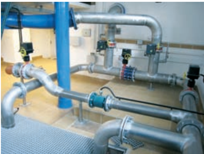
Obr. 4: Pohled na inovovanou ČS, dvě výtlačná potrubí, napájení čtyř měrných tratí
