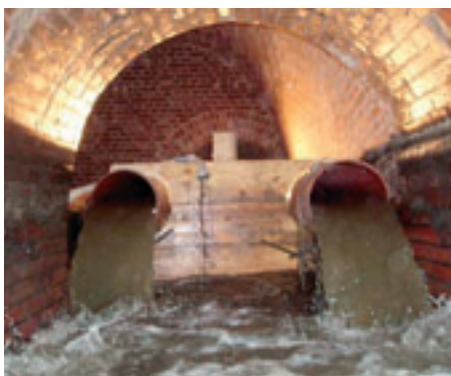
Vyústění obtokových potrubí do nátokové komory
