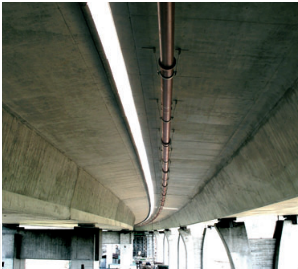
Obr. 1: Odvodnění mostu – celkový pohled
