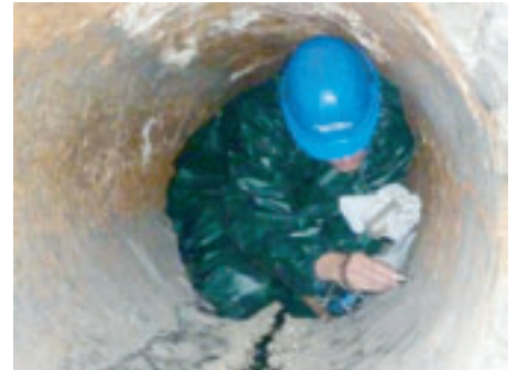
Měření tloušťky stěny litinového potrubí ultrazvukovým tloušťkoměrem
