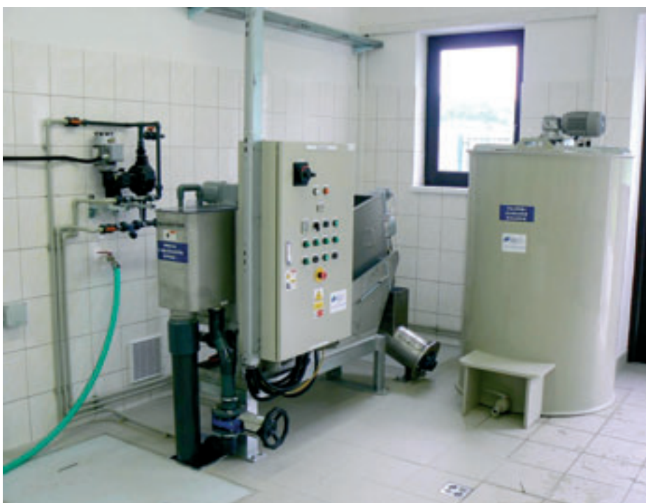
Obr. 2: Foto z realizace pro ČOV Kynšperk nad Ohří
