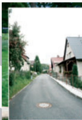
Projekt Čistě horní Labe – kanalizační systém aglomerace Vrchlabí Dílo stavebně dokončeno
