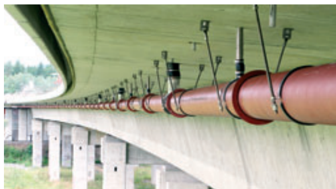
Obr. 13: Pohled na nainstalované potrubí
