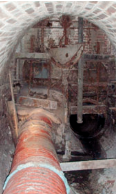
Nátoková komora – převedení vody do ramene DN 700
