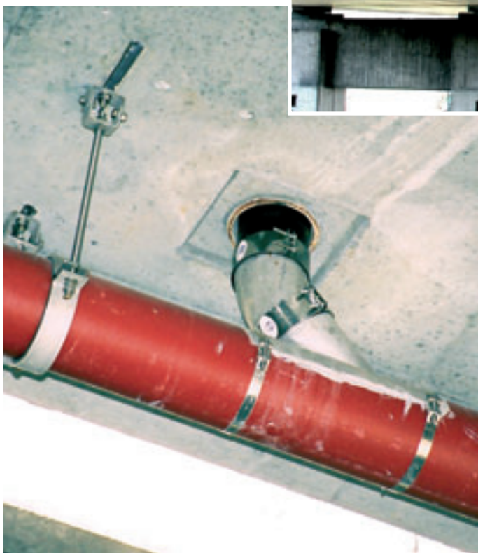
Obr. 2: Odvodnění mostu – detail napojení odvodnění mostovky
