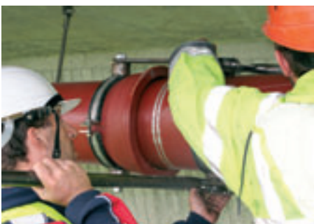
Obr. 9–11: Montáž hrdlového spoje
