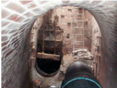
Nátoková komora – převedení vody do ramene DN 1000
