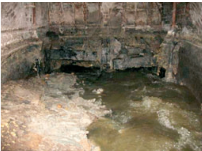
Zanesená nátoková komora shybky
