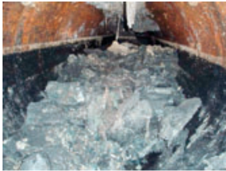
Sediment ve spojovací části ramene DN 1000
