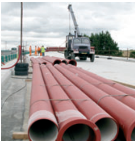
Obr. 4 a 5: Trubky INTEGRAL složené na stavbě
