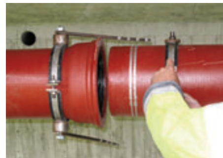
Obr. 8: Instalace montážního přípravku
