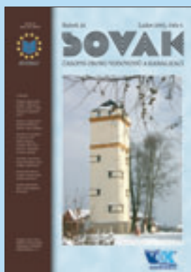
Titulní strana: Vodojem Horní Cetno. Vlastník a provozovatel: Vodovody a kanalizace Mladá Boleslav, a. s.
