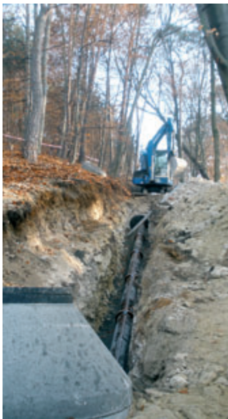
Láskov – dostavba kanalizace
