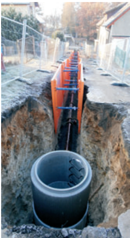
Láskov – dostavba kanalizace
