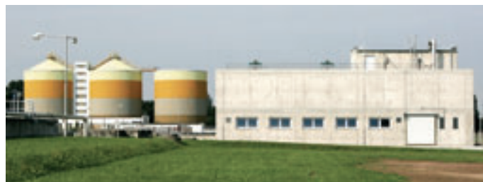
Obr. 4: Pohled na celou budovu PDN filtru na ČOV Hradec Králové
