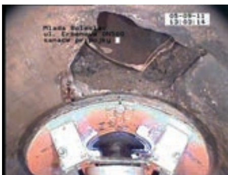
Injektování malty přímo z vozidla
