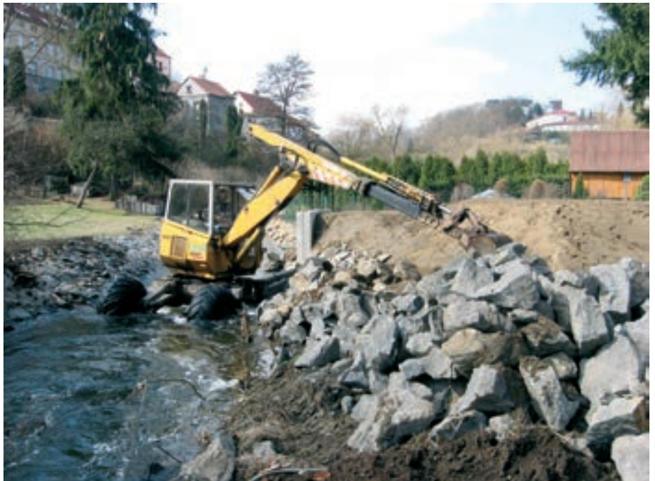
Fond soudržnosti – úprava pravého břehu u odlehčovací komory, Bezručova ulice
