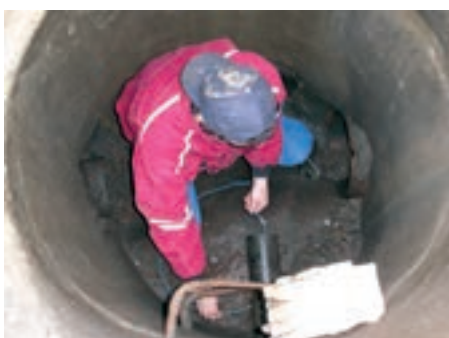
Obr. 5: Instalace záznamníku dat do revizní šachty
