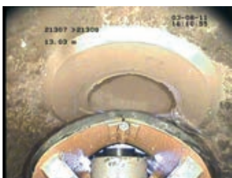
Zaústění kanalizačních přípojek opravených technologií ZEP-RE-CON
