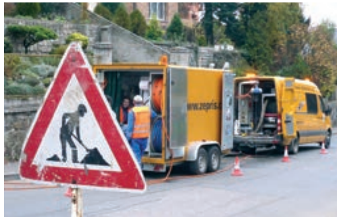
Jízdní souprava s kanalizačními roboty
