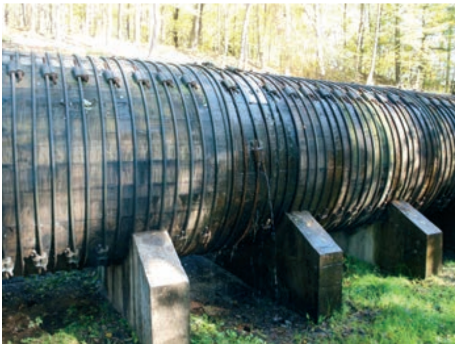
Obr. 6: Detail dužin stažených pomocí ocelových obručí (přívod z vodního díla Seč pro vodní elektrárnu)
