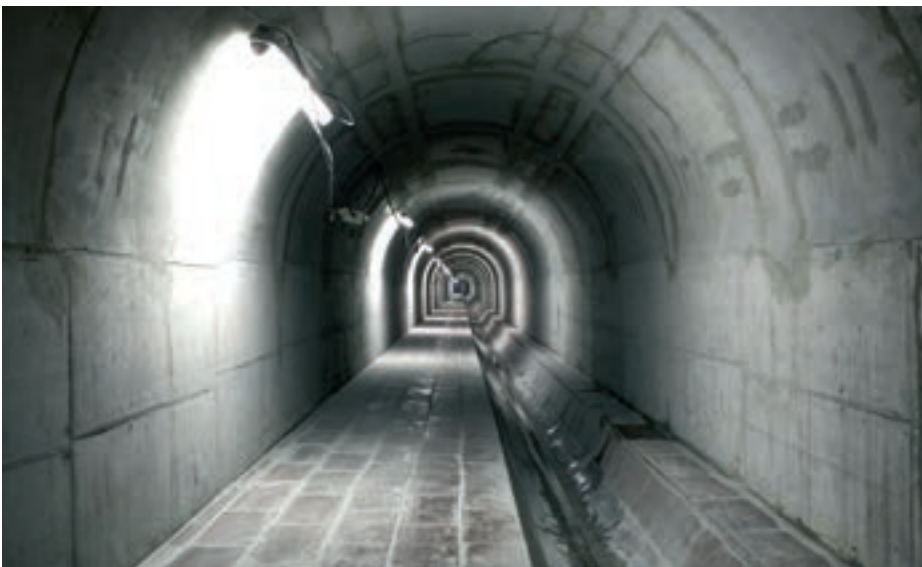
Kanalizační štola Jordán, Údolní ulice
