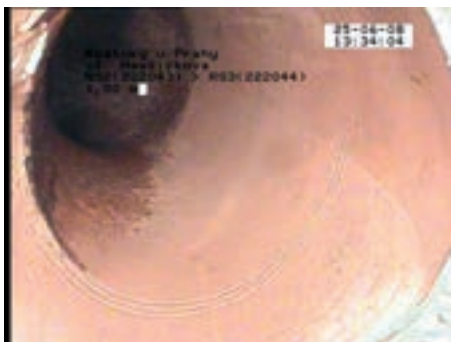
Pohled do přípojky z kamery robota. Střepy přípojky jsou usazeny do betonového lože
