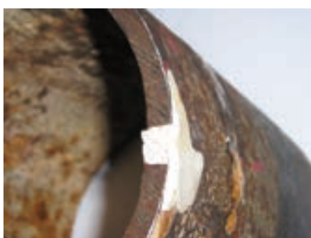
Foto 6: Pohled na opravu praskliny v potrubí produktem firmy Curapipe System (bez rozebírání potrubí, tedy intaktně na místě porušeného úseku)
