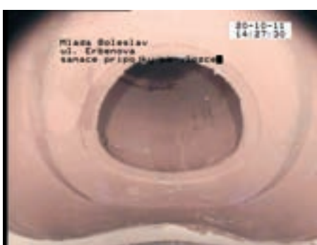
Zaústění kanalizačních přípojek opravených technologií ZEP-RE-CON
