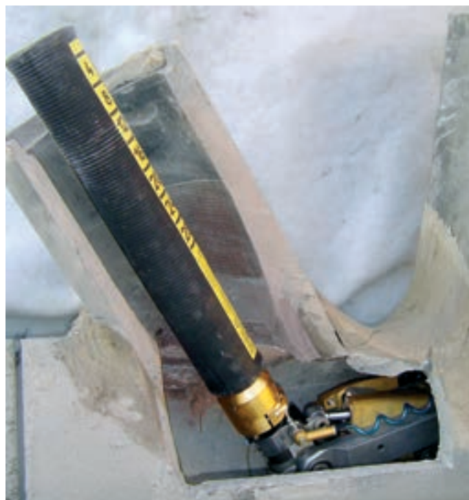
Zaslepená nepoužívaná přípojka
