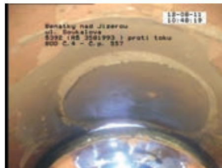
Zaslepená nepoužívaná přípojka
