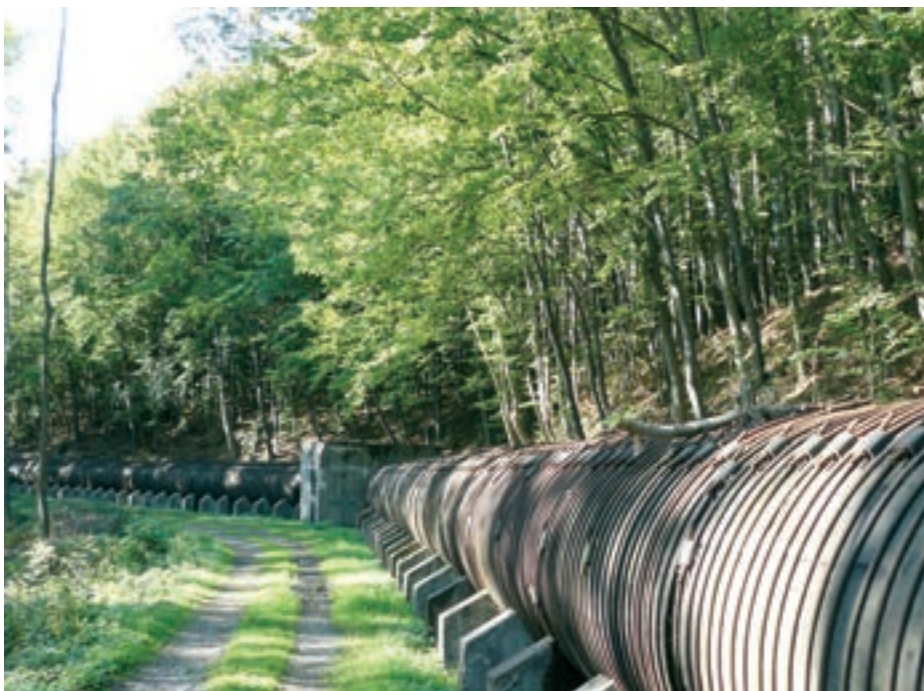
Obr. 5: Dnes již neexistující dřevěné dužinové potrubí DN 2000 (přívod z vodního díla Seč pro vodní elektrárnu)
