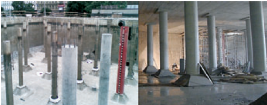
Obr. 6: Rekonstrukce vodojemu. Zesílení původních sloupů obetonováním, nový strop s lokálně podepřenou deskou, celoplošná adhezni sanace stěn
