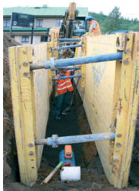
Z průběhu výstavby vodovodního přívaděče v katastru obce Kořenov
