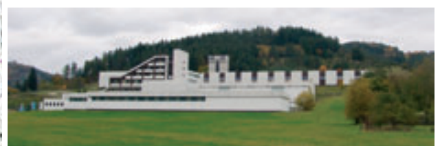
Obr. 3: Úprava vody Švařec
