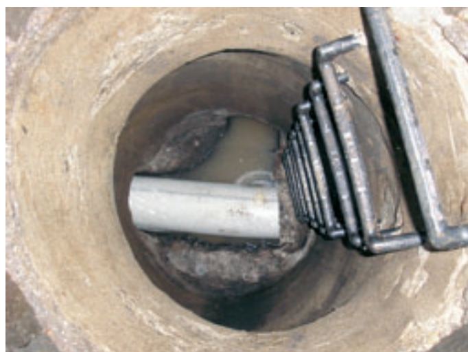
Provedení bezvýkopové technologie Wombat
