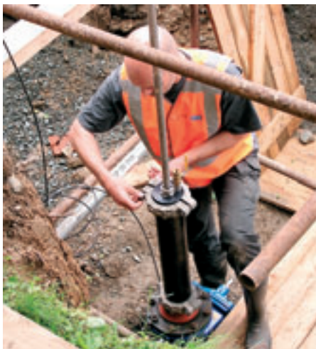
Obr. 4: Zavádění balónku přes nástavec do potrubí
