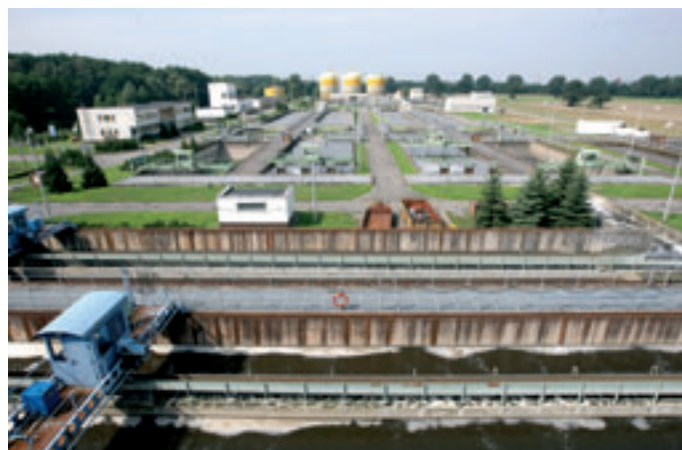
Celkový pohled na ČOV Hradec Králové
