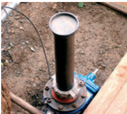
Obr. 2: Připravený nástavec na vložení balónku
