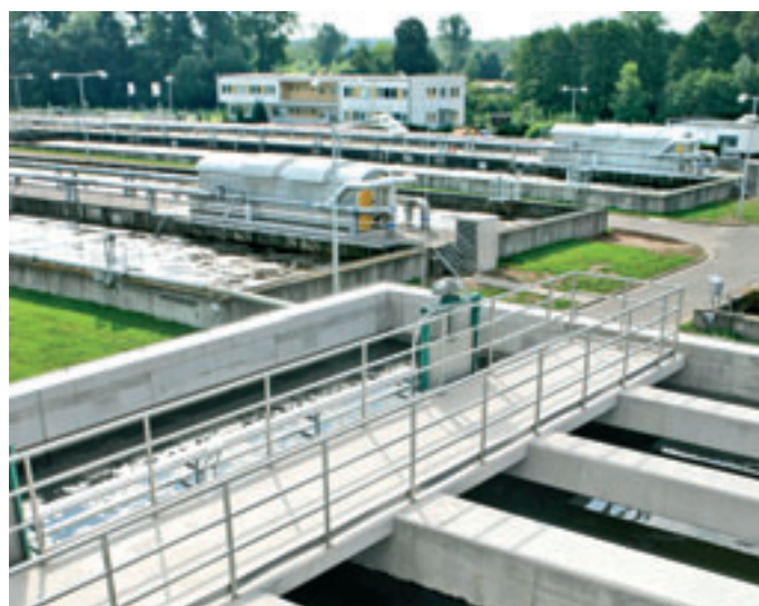
Pohled ze střechy PDN filtru na dmychárnu a provozní budovu ČOV
