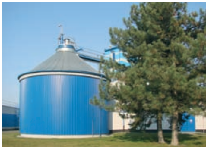
Rekonstruovaná čistírna odpadních vod Nový Jičín – vyhnívací věž
