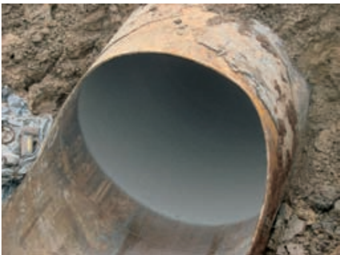
Sanace přivaděče DN 1600
