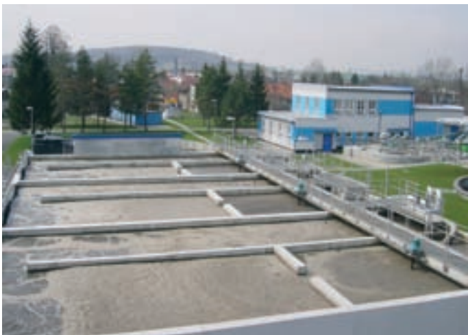
Rekonstruovaná čistírna odpadních vod Nový Jičín – detail aktivací nádrže – kaskáda
