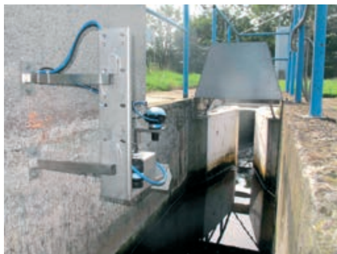
Obr. 5: Pohled na měrný Parshallův žlab P5 za měrným profilem
