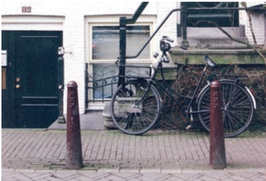
Dlažba z betonových tvárnic u amsterodamského grachtu obsahuje jako kamenivo vápenné pelety
