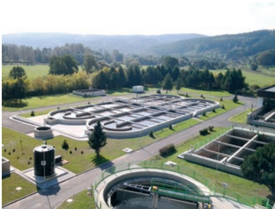
Čistírna po rekonstrukci – rok 2015
