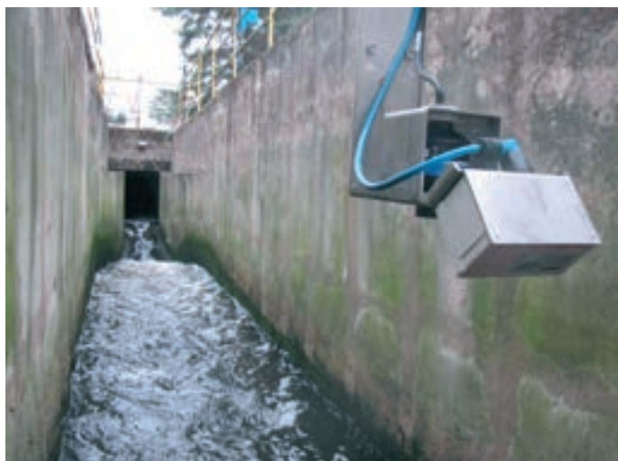
Obr. 9: Provedení instalace pod Venturiho žlabem na odtoku z DN 6, 8 na ÚČOV Praha
