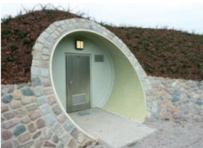
Vstup do manipulační komory. Foto: AMIANTIT Germany GmbH
