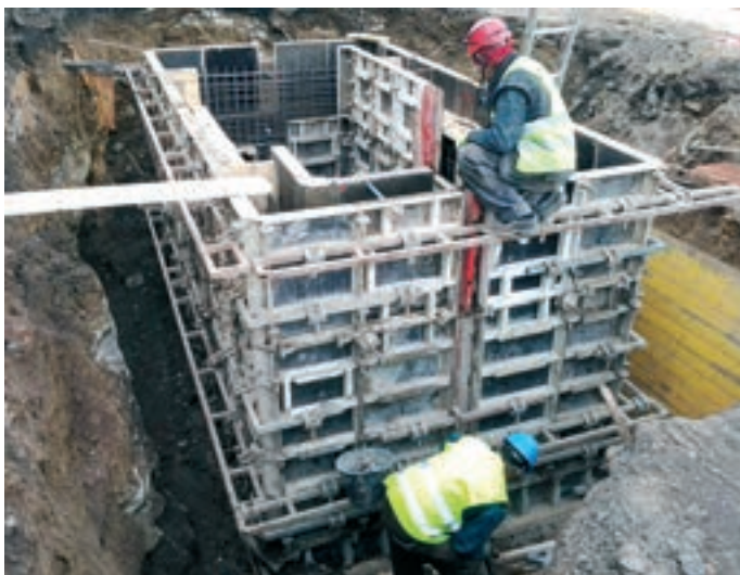
Betonování odlehčovací komory
