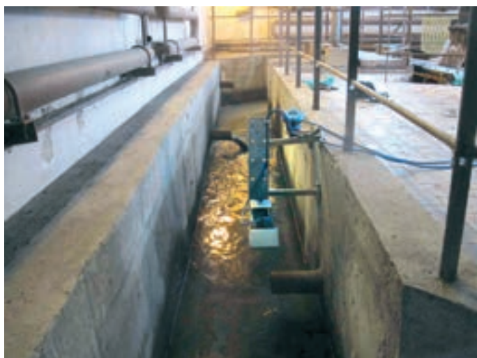
Obr. 7: Žlab mezi česlemi a lapáky písku na ČOV Kbely
