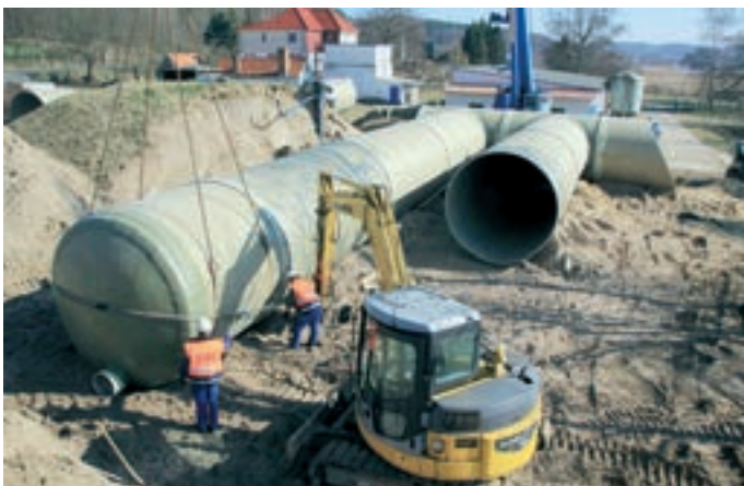
Montáž koncového kusu na jedné z komor nádrže. Foto: Dieter Lindemann, Sassnitz
