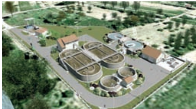
Střední Pomoraví/Hodonínsko, projekt č. 2 Strážnice – rekonstrukce a intenzifikace ČOV (po rekonstrukci)
