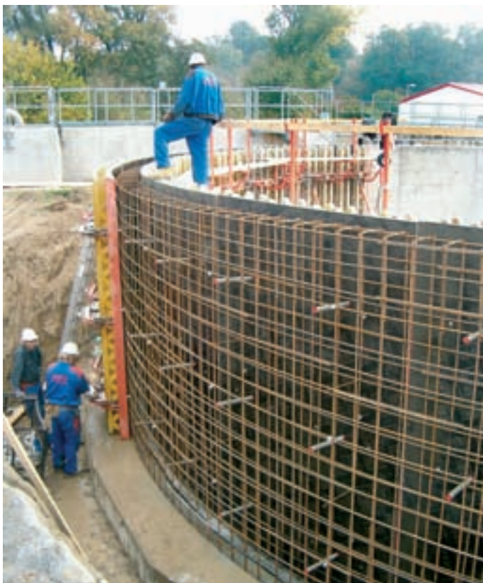
Střední Pomoraví/Hodonínsko projekt č. 6.1 Veselí nad Moravou – rekonstrukce ČOV
