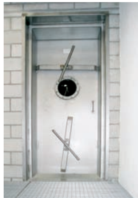
Obr. 3: Nerezové dveře do komory nově budovaného vodojemu ve Winterthuru
