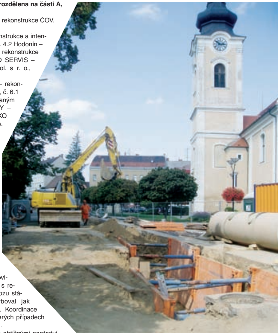
Střední Pomoraví/Hodonínsko projekt č. 4.1 Hodonín – rekonstrukce kmenových stok Národní třída
