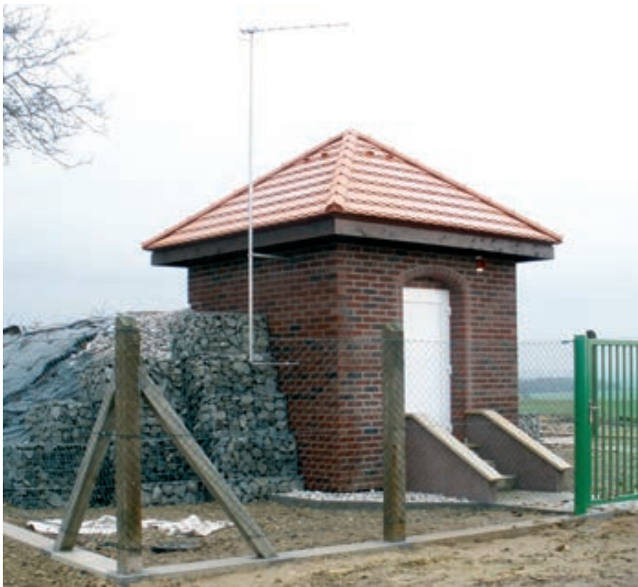
Obr. 1: Vodojem Bitouchov s anténou pro přenos telemetrických dat rádiovou datovou sítí
