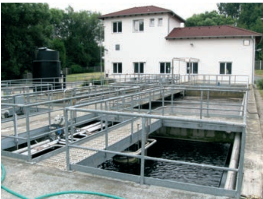
Obr 1: Nová ČOV před rekonstrukcí
