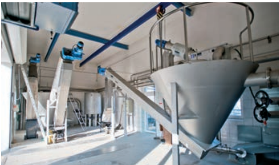
Obr. 4: Hrubé předčištění + rozdělovací objekt
