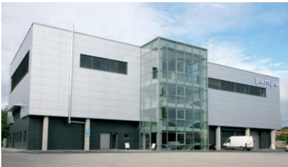
Centrála PUMPA, a. s., v Brně
